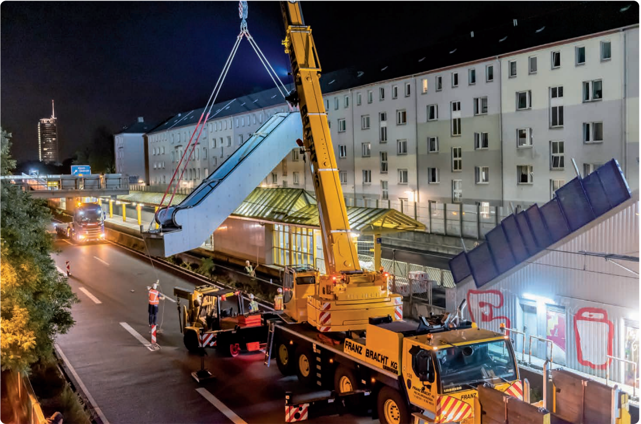
Eine der neuen 15 Meter langen und 12 Tonnen schweren Fahrtreppen wird nachts in Position gebracht. Schauplatz im August 2019 an der Haltestelle Savignystraße zwischen den gegenläufigen Autobahnspuren der A40 mitten in Essen. (Quelle: thysssenkrupp)
